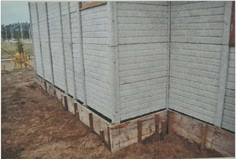
ENCOFRADO TRADICIONAL DE MADERA PARA EL LLENADO DE LA VIGA DE CIMENTACIÓN
