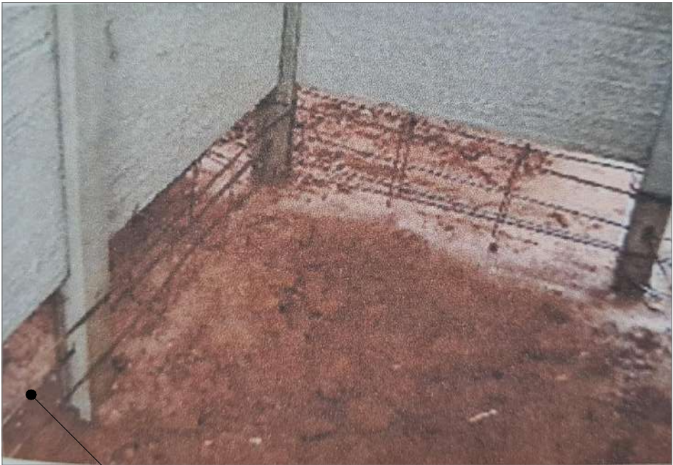
VARILLA de RIOSTRA de los pilares previa construcción de la V.F
